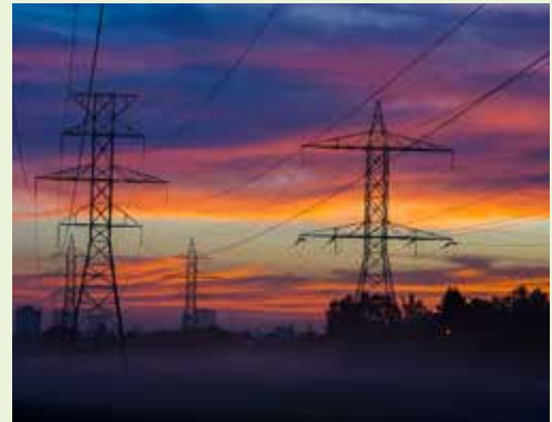
Torres de transmissão de energia elétrica.
