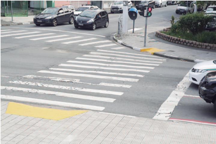
O prefeito solicitou o reparo no passeio, rebaixamento de guias e construção de rampas de acessibilidade
