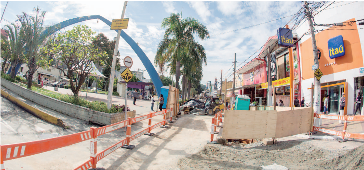
A Eletropaulo já iniciou a obra para transformar a rede elétrica aérea em subterrânea
